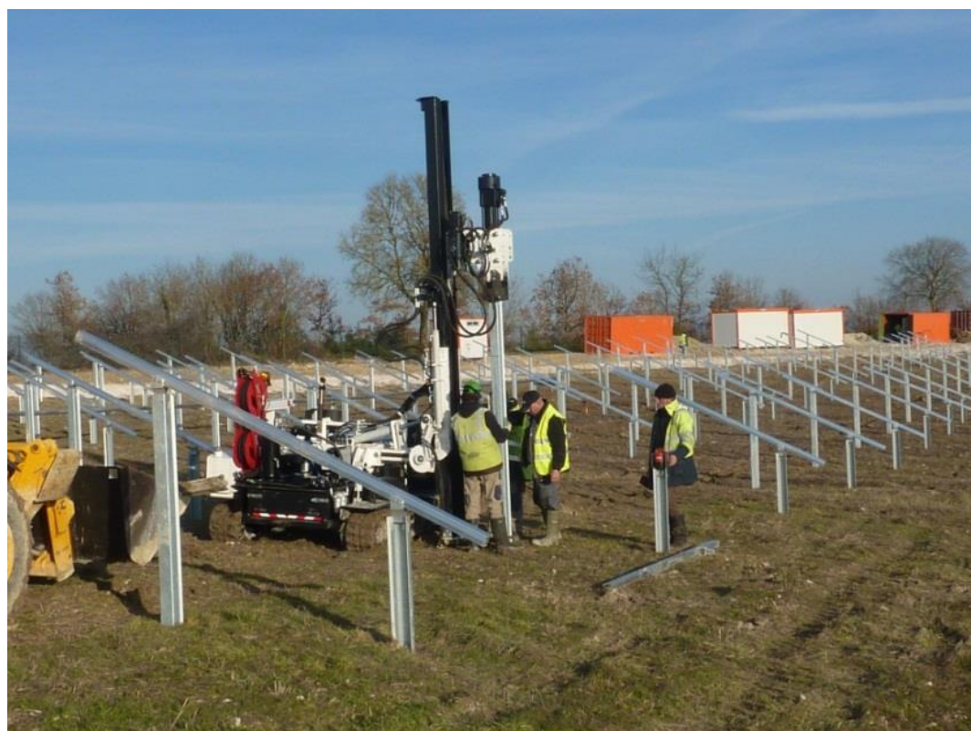
Figure 3 : Mise en place de support de panneaux
