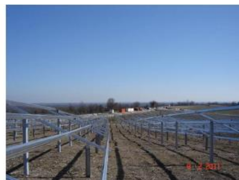
Fixation des rails de support
