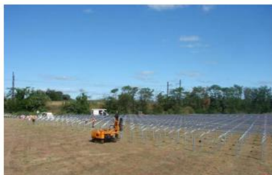
Battage des pieux
